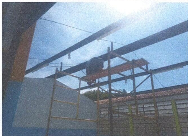
Foto1: Trabajos de cambio de techo
