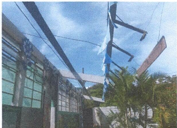
Foto 3: Trabajos de cambio de canales
