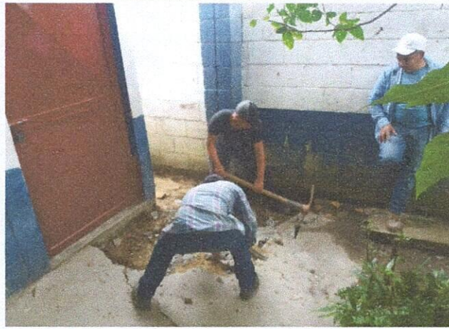
Foto 2: Trabajos de remoción de banquetas
